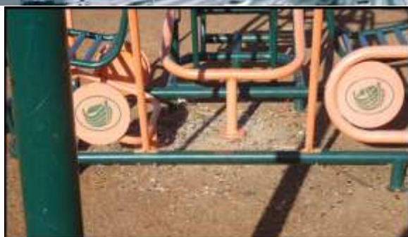
Figura 20: Equipamento da API/ATI após ação de vandalos na Praça Jardim Tropical 1
