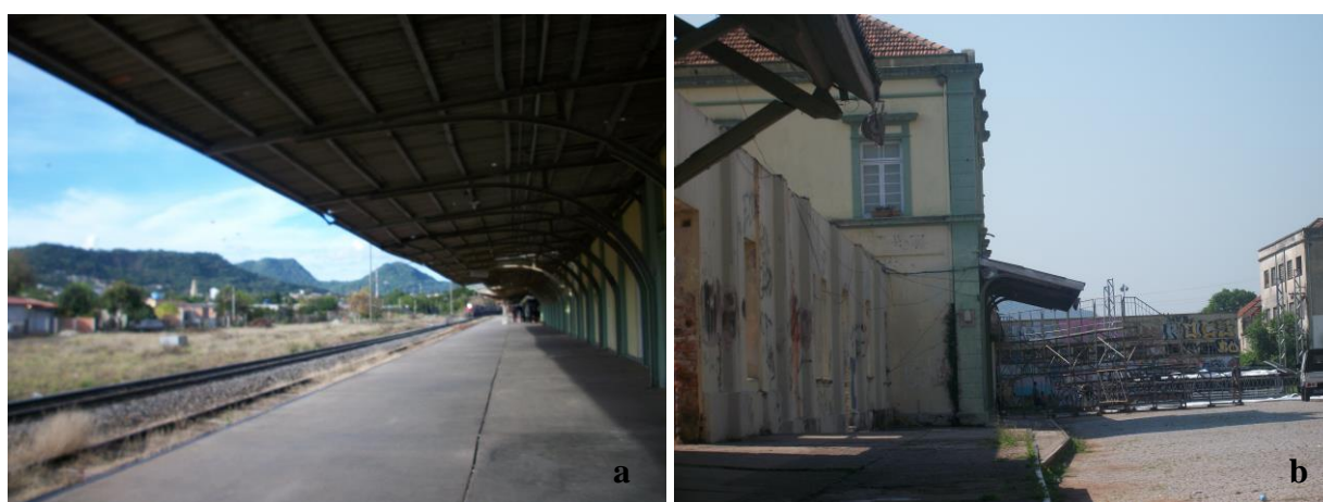
Figura 4: a e b) Vista parcial da Gare da Estação Férrea.
