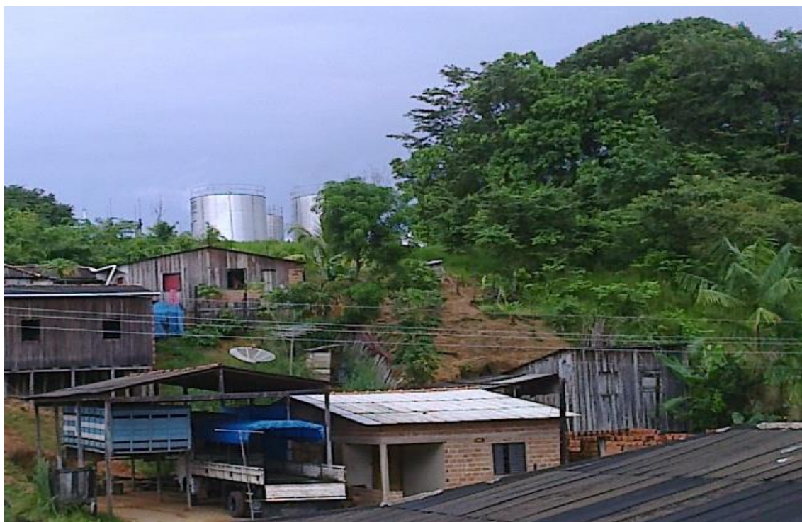
Figura 4- Moradia em área de risco em Oriximiná
