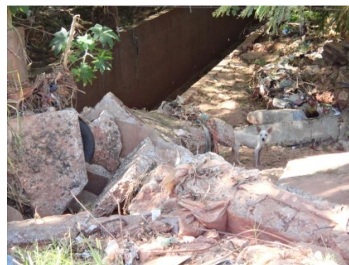
Figura 8: canal para escoamento de águas pluviais no Córrego Fonte: GONÇALVES e GONÇALVES 2013
