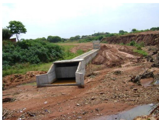
Figura 3: edificação de infraestrutura para canalização de parte do Córrego Fonte: GONÇALVES, 2009
