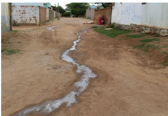
Figura 6. Esgoto a céu aberto numa rua sem pavimentação
