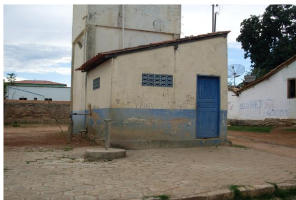
Figura 10. Poço em Maniaçu lacrado devido o alto teor de contaminação de urânio
