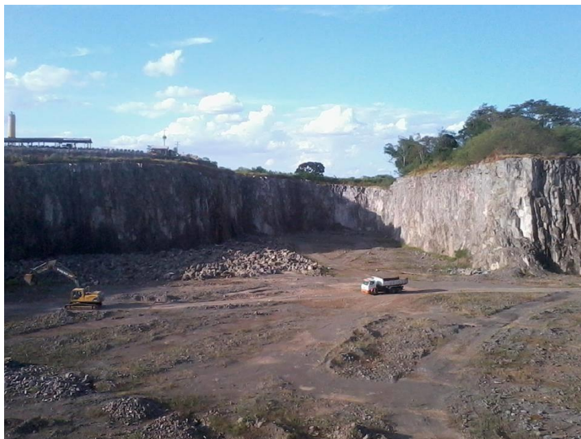
Figura 2 – Área de Detonação.
