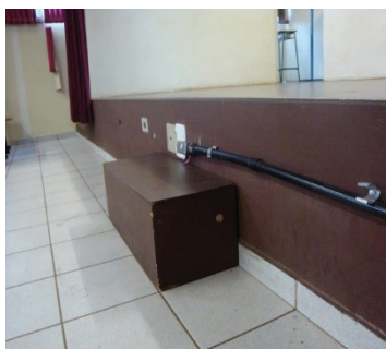
Detalhe do acesso ao palco do Salão Nobre do Colégio Estadual.
