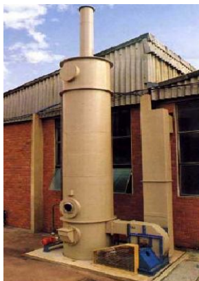
Figura – 6: Lavador de gases.
