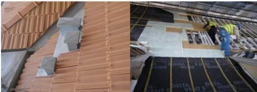
FIGURA 11 – Reabilitação das coberturas dos edifícios do MAOT. Fonte: Adaptado de FARINHA(2011) e RIBEIRO (2011).
